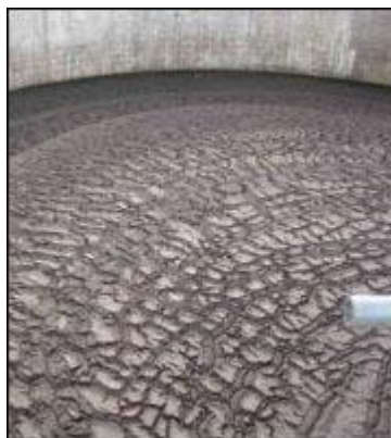
Boues d'épuration stockées dans un silo après traitement.
