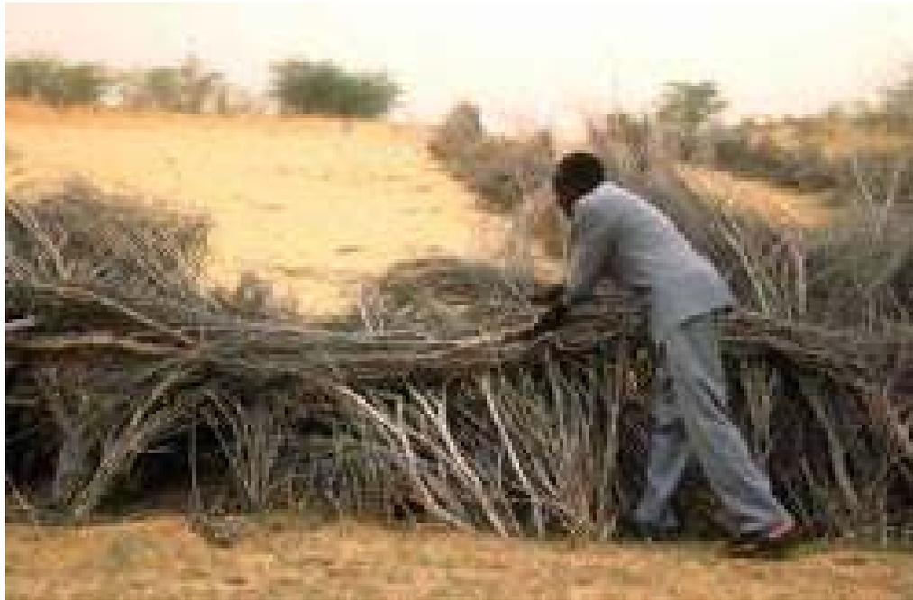
**Photo 43 : Fixation des dunes en milieu saharien par la technique de palissades**
