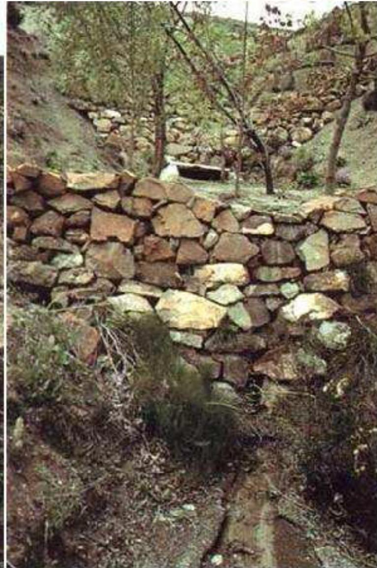
**Photo 37 et 38 : Lutte contre l'érosion hydrique par correction des ravins**
